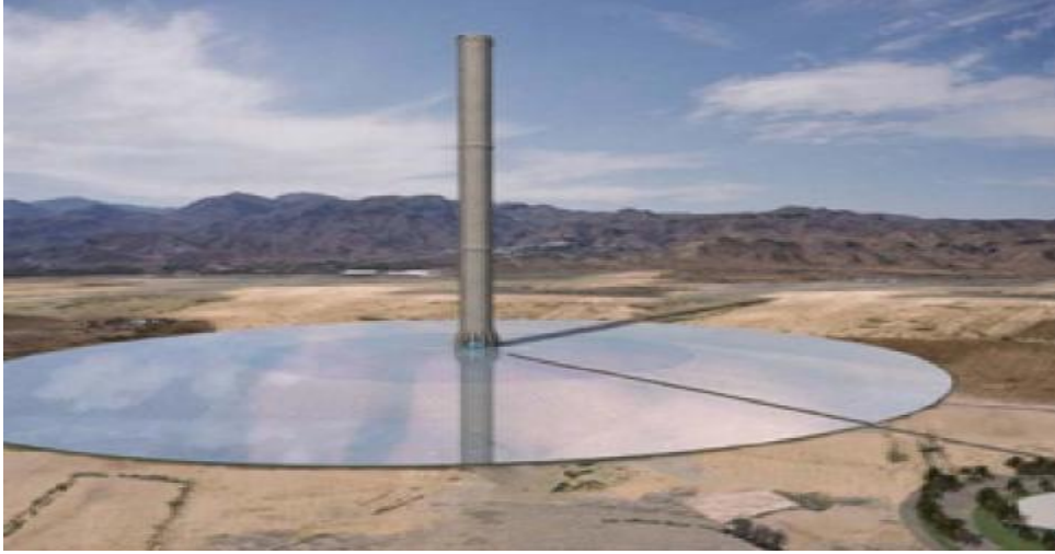
الشكل (٣) صورة فوتوغرافية لمدخنة شمسية
