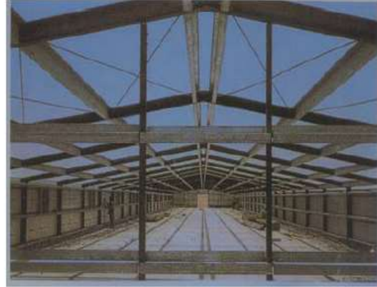
شكل ( ). المباني سابقة التجهيز (الهيكل المعدني ثم المواد العازلة للحرارة)
