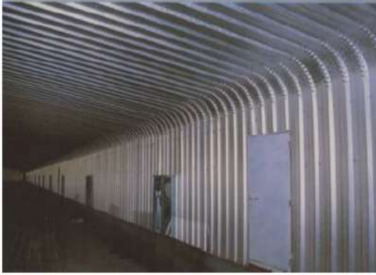
شكل ( ). المباني سابقة التجهيز (الهيكل المعدني ثم المواد العازلة للحرارة)
